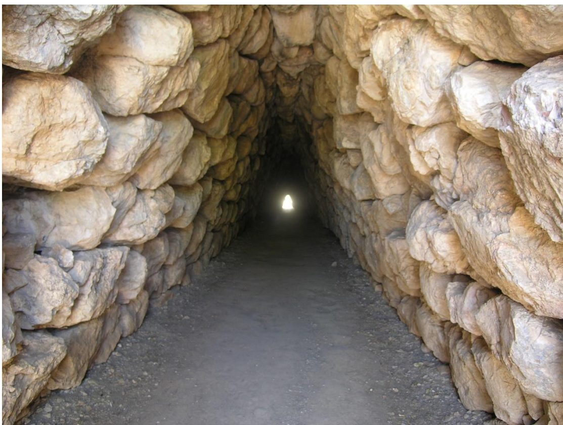
Figura 3. Yerkapi em Hattusa (capital do império hitita). Nela observamos uma construção que utiliza os arcos corbelados.
