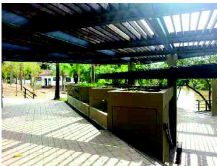
Figura 18 Ripado. Projetado pelo Escritório Burle Marx para espaço de exposição e lojas, e, até a data da visita, também se encontrava abandonado.
