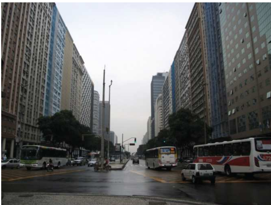
Figura 6 Edifícios comerciais de elevado gabarito na avenida Presidente Vargas. Foto: Adilson de Souza Moreira, nov. 2011.
