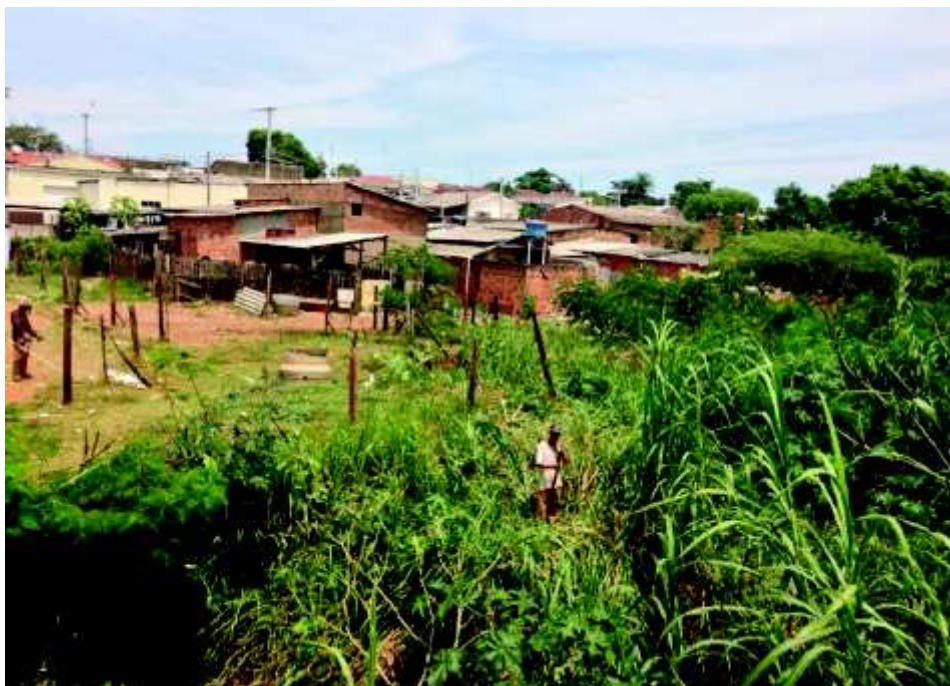
Figura 10 Visita de campo feita pela equipe do PET. Ocupação das margens do córrego da Lagoa. A prefeitura já iniciou o processo de remoção de famílias em áreas de risco junto ao córrego. Foto: Danilo Pena Maia, 2015.
