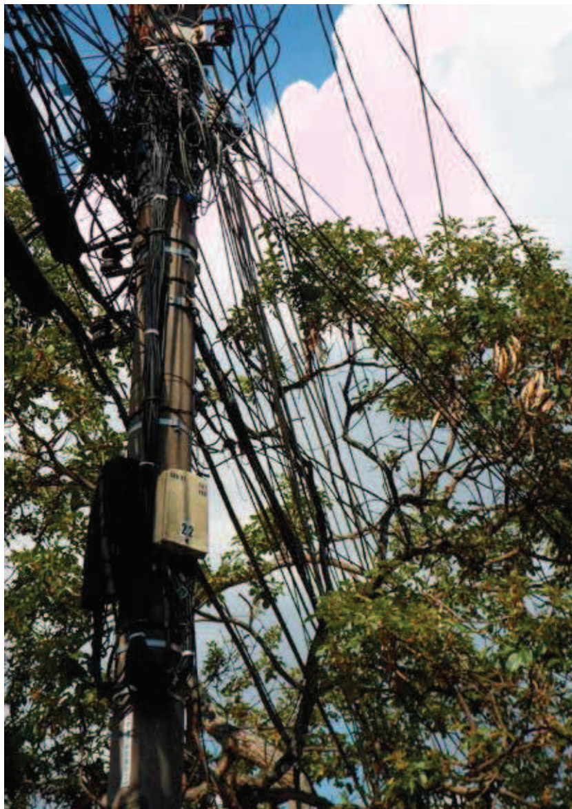
Figura 1c Conflitos aéreos e subterrâneos com a arborização. Rua Ibituruna, Parque Imperial, São Paulo (SP). Foto: Roberto Vignola Junior – 2014
