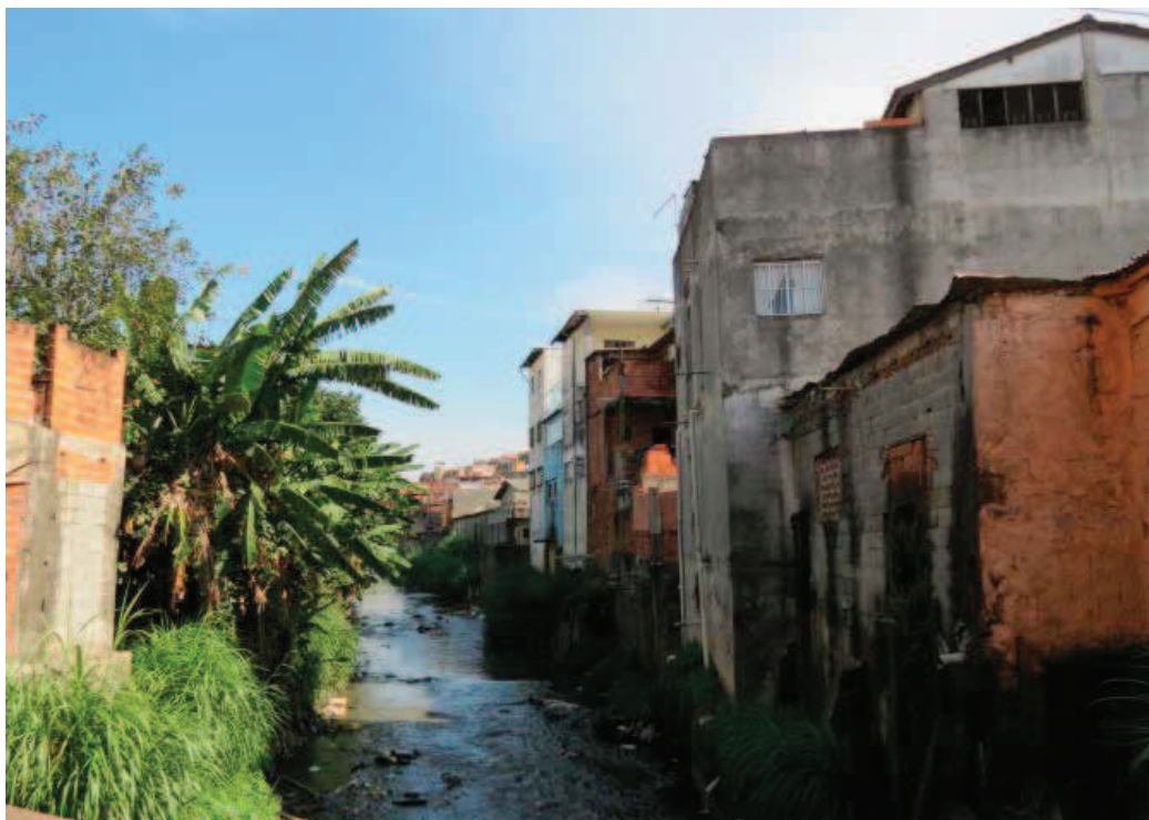
Figura 4 Ocupação das margens do rio Piqueri com lançamento de esgoto no corpo hídrico. Foto: Gerson Amaral – 2014
