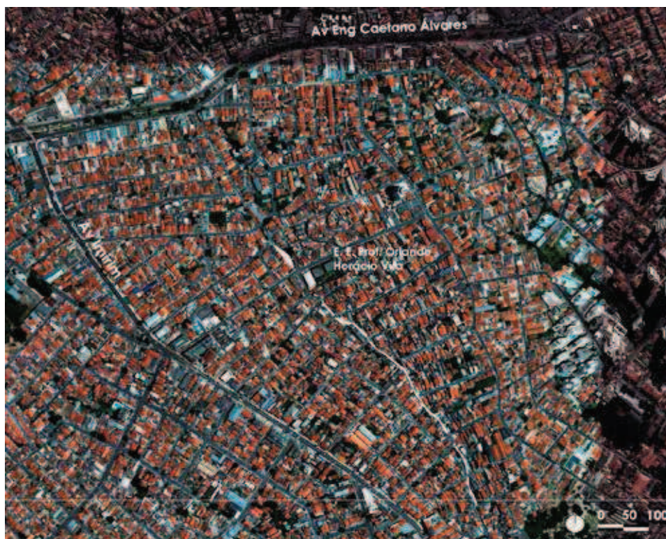
Figura 4 O entorno do córrego das Cobras na atualidade.
