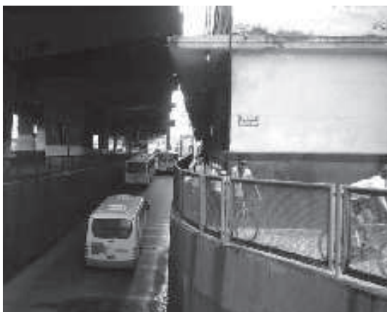
Figura 12: Trecho de barreira física e visual causada pela Perimetral e pelo Mergulhão, com estreita passagem de acesso à praça XV junto do Edifício da Conab
