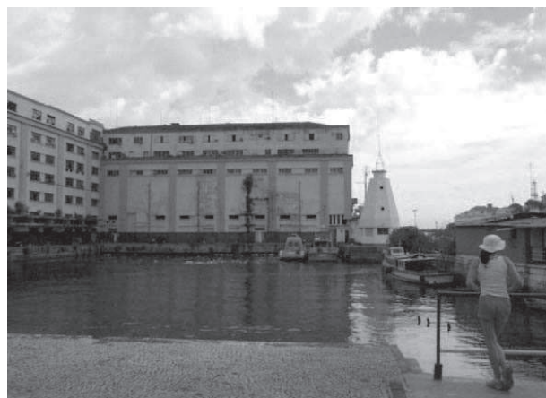
Figura 13: Edifício da Conab construído junto do antigo Cais do Mercado, hoje desativado e sem função. O aspecto sujo e deteriorado dessas águas não convida o olhar à contemplação e à fruição, apesar de ser o cais, hoje, o único ponto de contato direto da praça XV com as águas da baía de Guanabara
