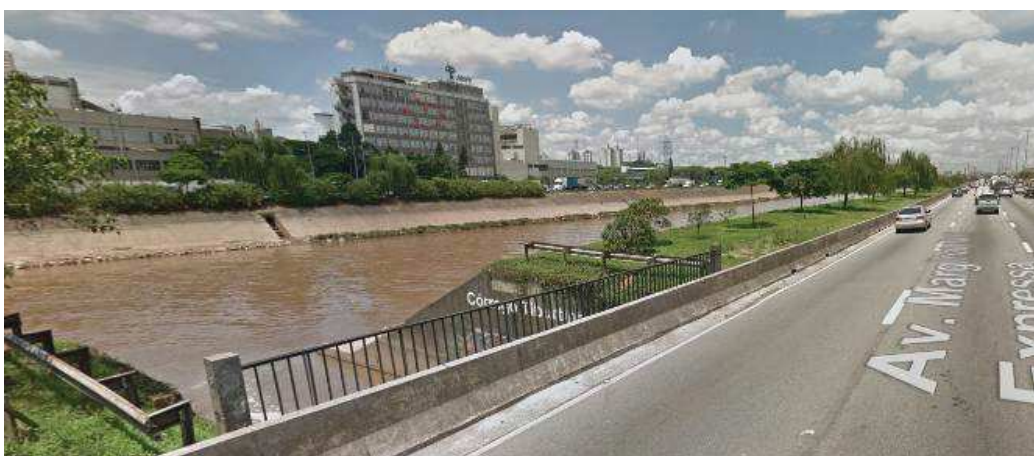
Figura 15 Foz do córrego Tiburtino. Fonte: Google Street View. Disponível em: < https://www.google.com.br/maps/@-23.5088185,-46.7011788,3a,75y,55.11h,79.49t/data=!3m7!1e1!3m5!1sDykbttqYtdzK3Yq9hrwi-g!2e0!5s20141101T000000!7i13312!8i6656?hl=pt-BR&authuser=0 >. Acesso em: 28 ago. 2017.
