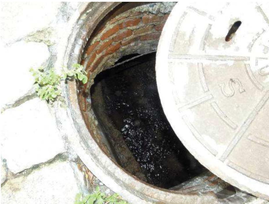
Figura 11 Bueiro por onde pode se ver mais uma vez o córrego. Foto: Murillo Aggio Piazzi, abr. 2014.
