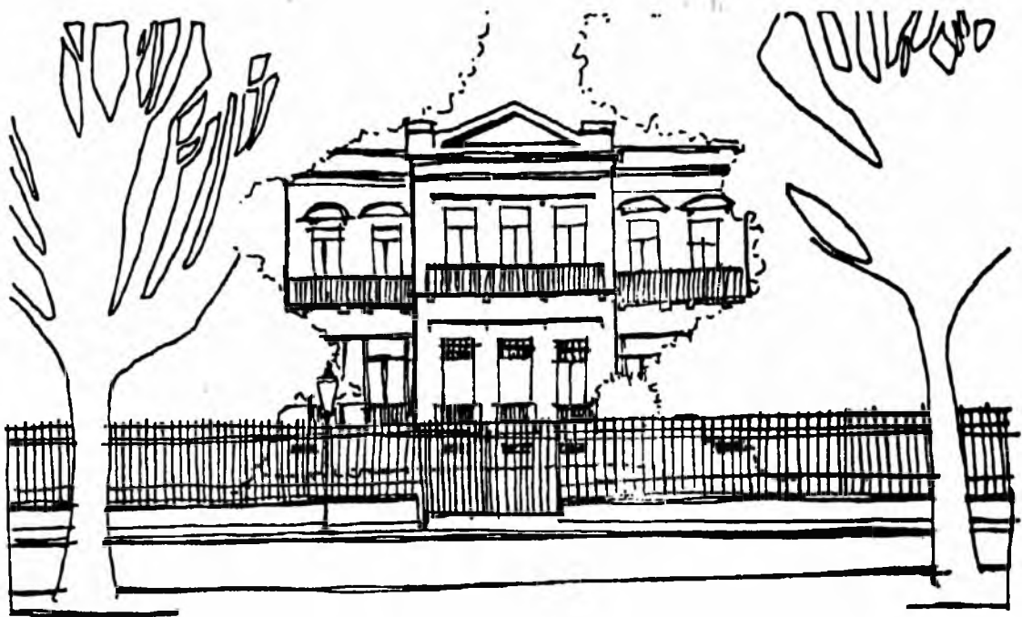
Antiga residência de Augusto de Souza Queiróz, na esquina das ruas Epitácio Pessoa (atual avenida Ipiranga) e Sete de Abril, onde hoje está o Edifício Esther.
