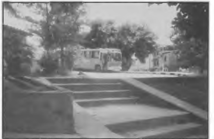
Foto 33: Terminal de ônibus, Plataforma
