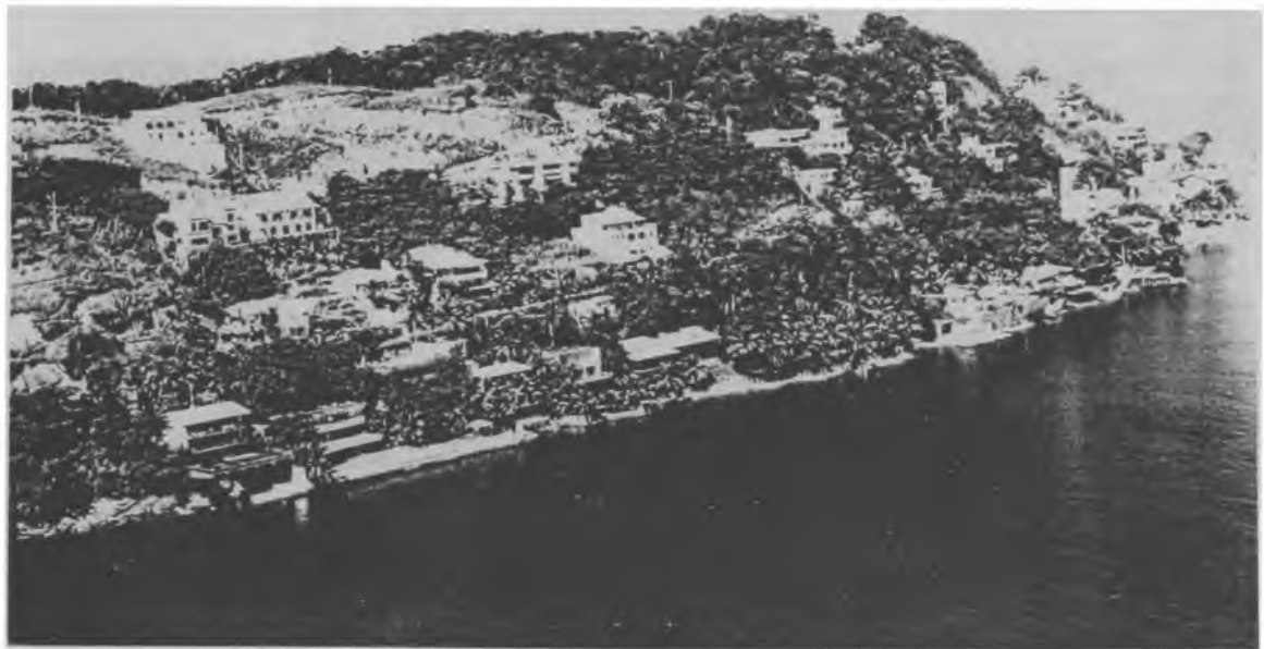
Vista geral do setor (01). A construção dos caminhos do loteamento exigiu cortes profundos no morro, com sinais evidentes de erosão.
