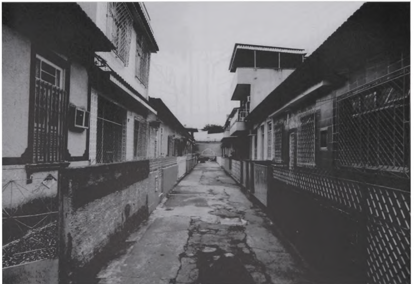
Vila em Piedade, apresentando acréscimos de pavimento Fonte: Foto de Marcos London, 1999 – Arquivo PUZN
