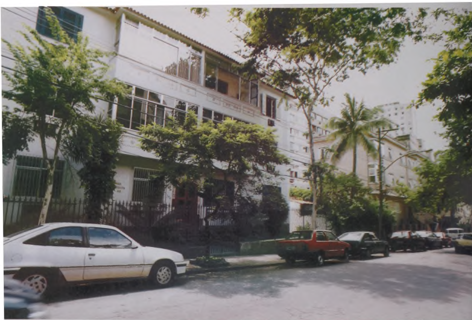
Prédio de três pavimentos, em Laranjeiras Fonte: Foto de Marcos London, 1999 – Arquivo PUZN
