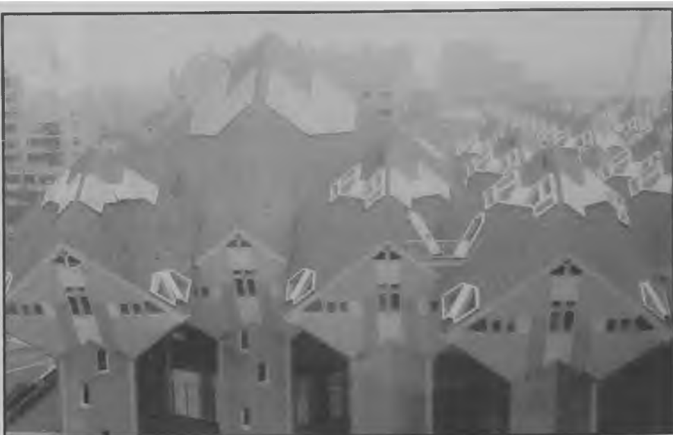
Figura 11: Conjunto Residencial Piet Blom – Rotterdam, Holanda Foto da autora, 1985
