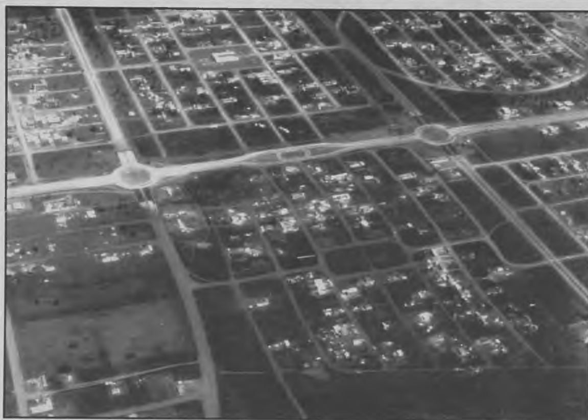
Vista aérea de Palmas, capital do estado do Tocantins, onde o parcelamento dos bairros residenciais se fez de modo convencional, com movimento de solo importante e com a erradicação da vegetação Foto: Marcos Castilha, 1992
