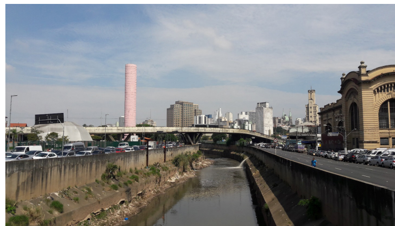
Figura 12 – Acesso ao Sesc Dom Pedro II a partir da Avenida Mercúrio. Destaque para a área do antigo parque ocupada pelo Viaduto Diário popular, Av. dos Estados e Rio Tamanduateí. Foto: Ciro Vidotte, maio 2019.
