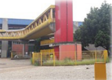
09 - Estação Pedro II do Metrô
