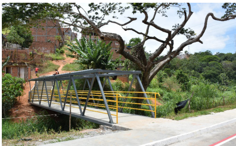
Figura 5: Em primeiro plano, a linha que demarca a ciclovia, ponte sobre o Rio Mocambo e escada de acesso. Fotos: Thiago Jr., fevereiro de 2018.
