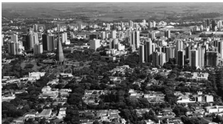
Figura 23: Maringá. Região central Fonte: Acervo dos autores, 2005
