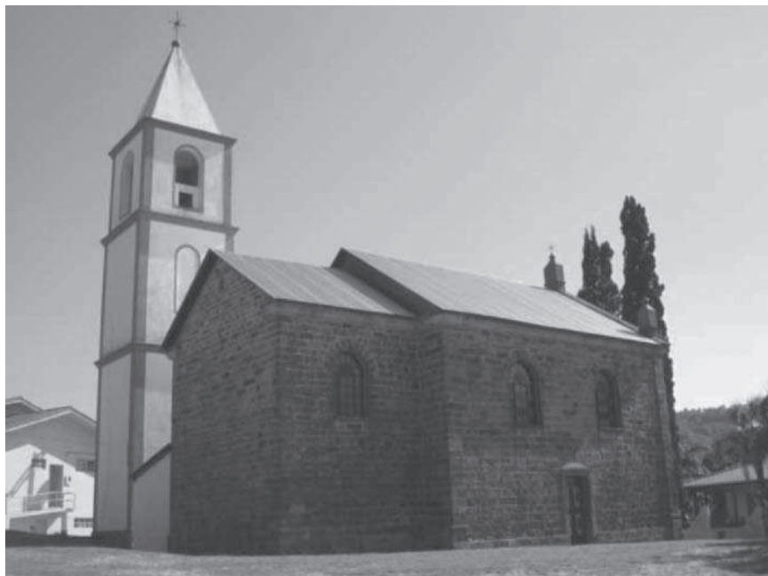
Foto 4: Igreja São Gervásio e São Protásio – 1912 (localidade de rio Maior – Urussanga/SC). Excepcional exemplar da arquitetura religiosa italiana, construída em pedra arenito. Planta constituída por capela-mor e nave principal. Possui campanário, construído em 1940 em substituição ao de madeira, separado do corpo da igreja Crédito: Virgínia Gomes de Luca
