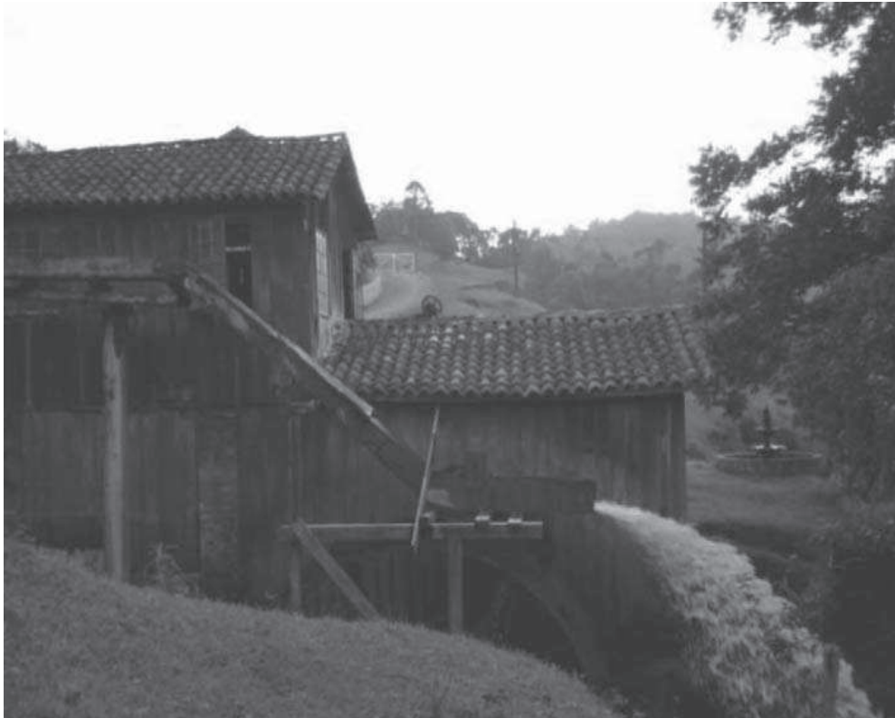
Foto 3: Propriedade rural da família Bez Fontana – 1901 (localidade rio América Baixo – Urussanga/ SC). Principal exemplar em madeira da região, conserva em perfeito estado o sobrado residencial de madeira, a cozinha separada do corpo principal em alvenaria de tijolos, e unidades de produção como serraria, atafona, marcenaria e descascador de arroz movido à roda d'água.
