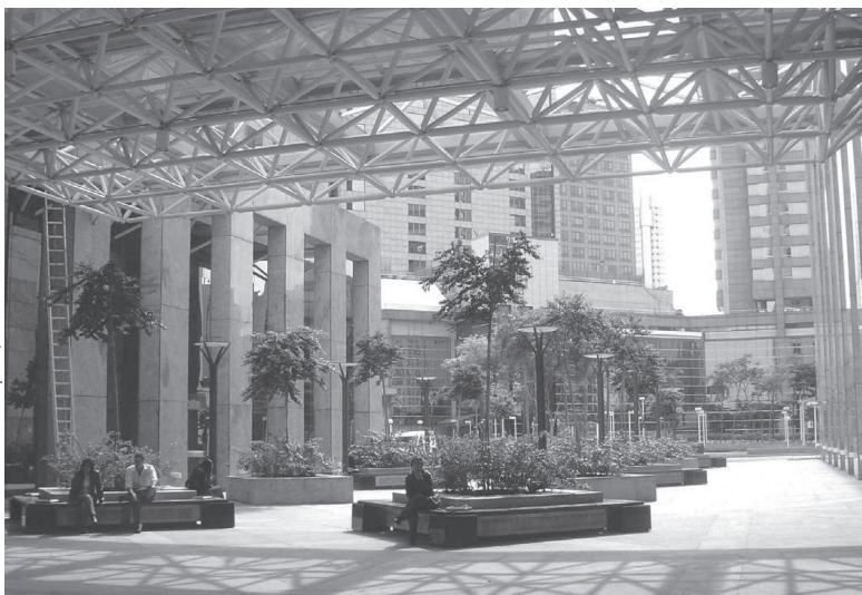
Figura 6: Praça corporativa articulando as três torres e o shopping center do Centro Empresarial Nações Unidas, na Marginal do Pinheiros, com projeto paisagístico do escritório DW/Santana
