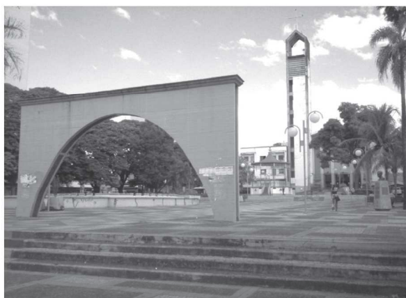
Figura 8: A impermeabilização da área como diretriz principal do projeto Foto de Amanda Rafacho
