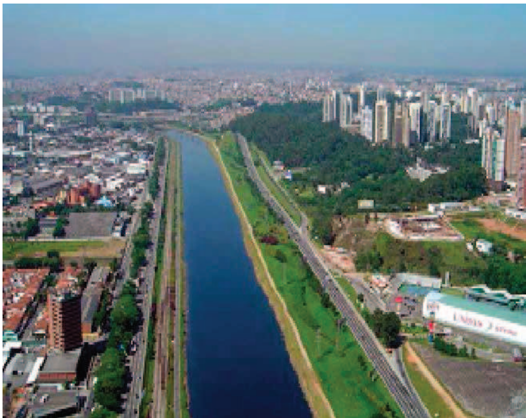
Figura 5 Rio Pinheiros, em São Paulo (SP). Esgoto a céu aberto, margens ocupadas por vias expressas, várzeas impermeabilizadas, (ir)racionalidade capitalista. Foto: Acervo QUAPÁ – 2005.
