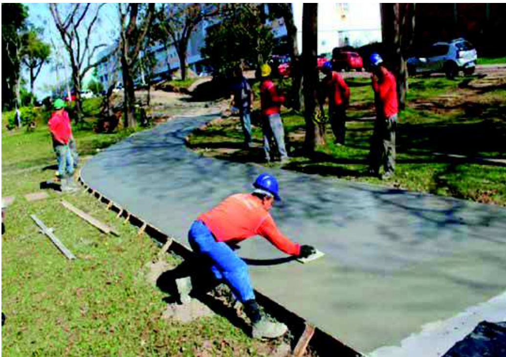
Figura 15 Execução da Pista Multiuso iniciada em julho. Vista 2. Foto: Felipe Gravina, 2014.
