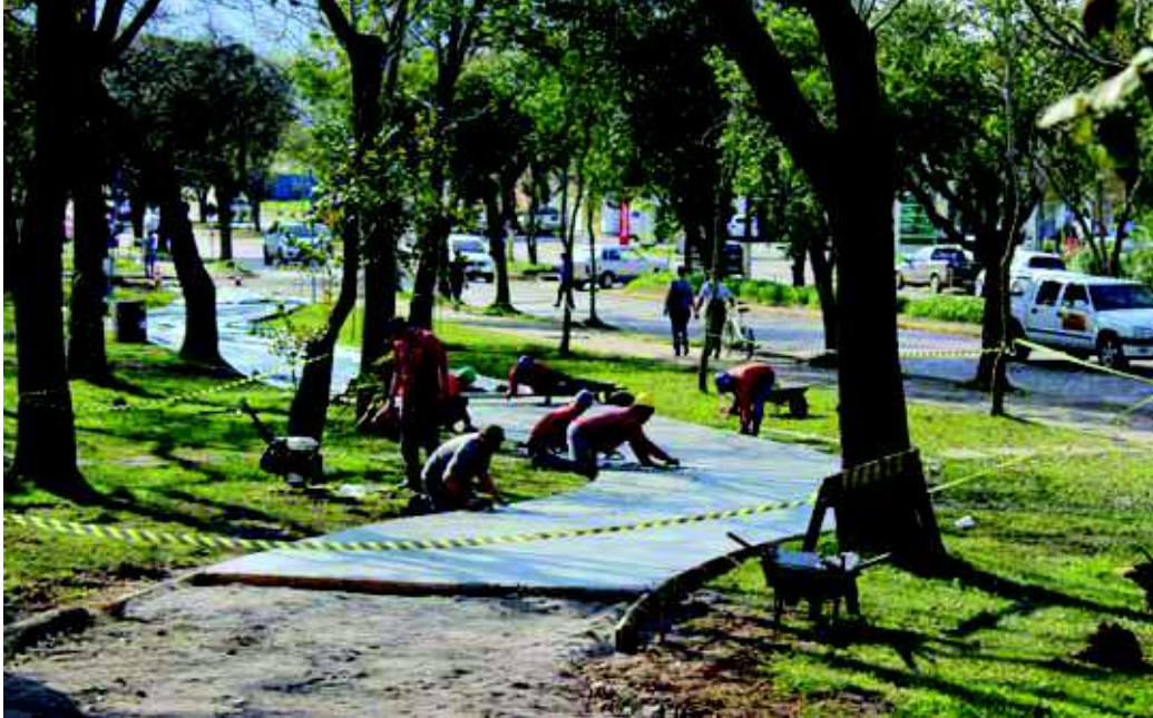
Figura 14 Execução da Pista Multiuso iniciada em julho. Vista 1. Foto: Felipe Gravina, 2014.
