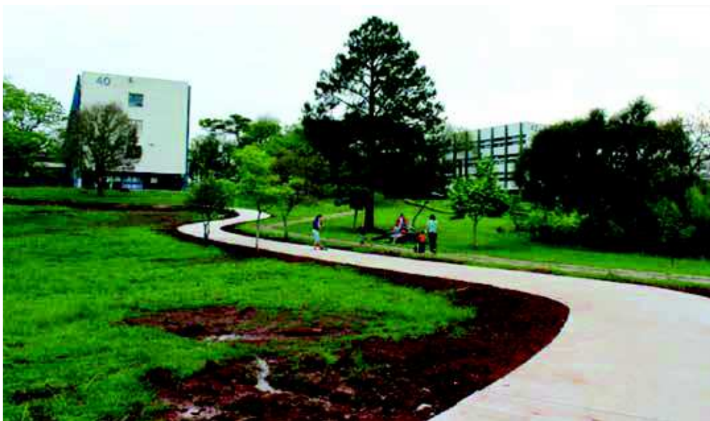
Figura 13 Acúmulo de água sobre o gramado em um local onde foi prevista intervenção de paisagismo com vegetação adequada para áreas alagadas. Foto: Luis Guilherme Aita Pippi, 2014.
