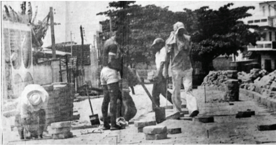
Figura 12 Operários trabalhando na pavimentação da avenida Jerônimo Monteiro em 1977. Fonte: Jornal A Gazeta (1977, p. 1).
