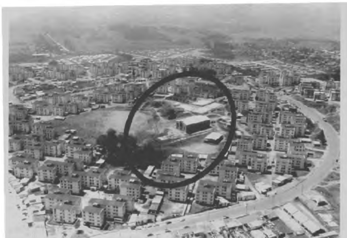
Figura 56: A construção de uma grande igreja ocupa parte do Parque Central e reduz ainda mais sua área original Fonte: PMPA
