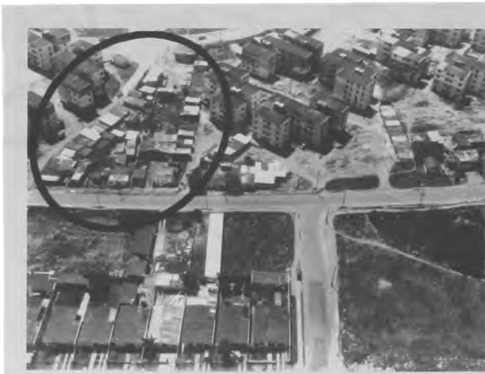
Figura 64: Novas ruas de moradia e comércio construídas com os fundos para as garagens de blocos de moradia, gerando unidades espaciais independentes Fonte: PMPA
