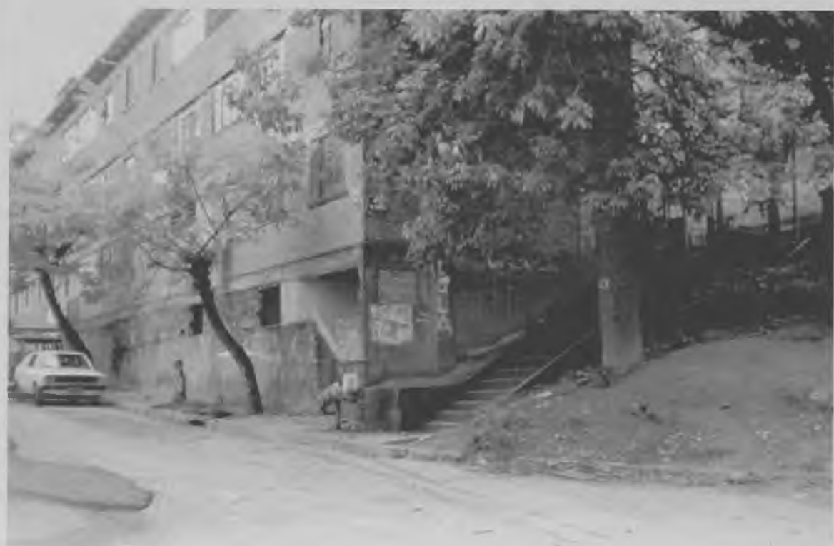
Figura 74: Intervenção em uma tipologia de edifícios implantados entre duas vias, onde apenas uma apresentava entrada para os edifícios, em um setor de Carapicuíba: nos antigos fundos dos edifícios são criadas ligações ao longo do perímetro do novo quarteirão e, ao mesmo tempo, são abertas garagens e pequeno comércio sob os edifícios, definindo relações bilaterais com o outro lado da via, na qual já estão presentes as frentes dos edifícios. Com isso, ambos os lados das vias possuem transições entre espaço público e privado
