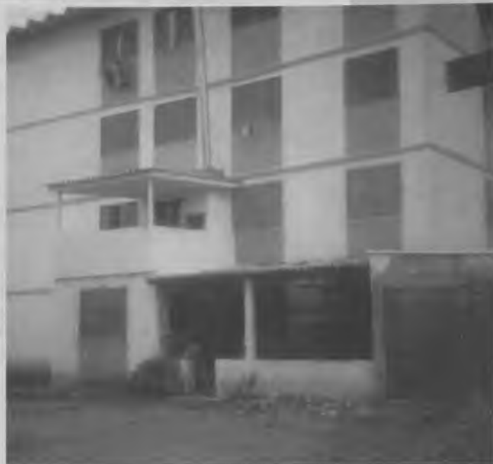
Figura 45: Exemplo de ampliação de apartamento térreo, estendendo-se para andares acima. Neste caso, além da área construída, foi privatizada uma área de pátio de acesso exclusivo desta unidade, além de garagem privativa Fonte: cedida pelo autor
