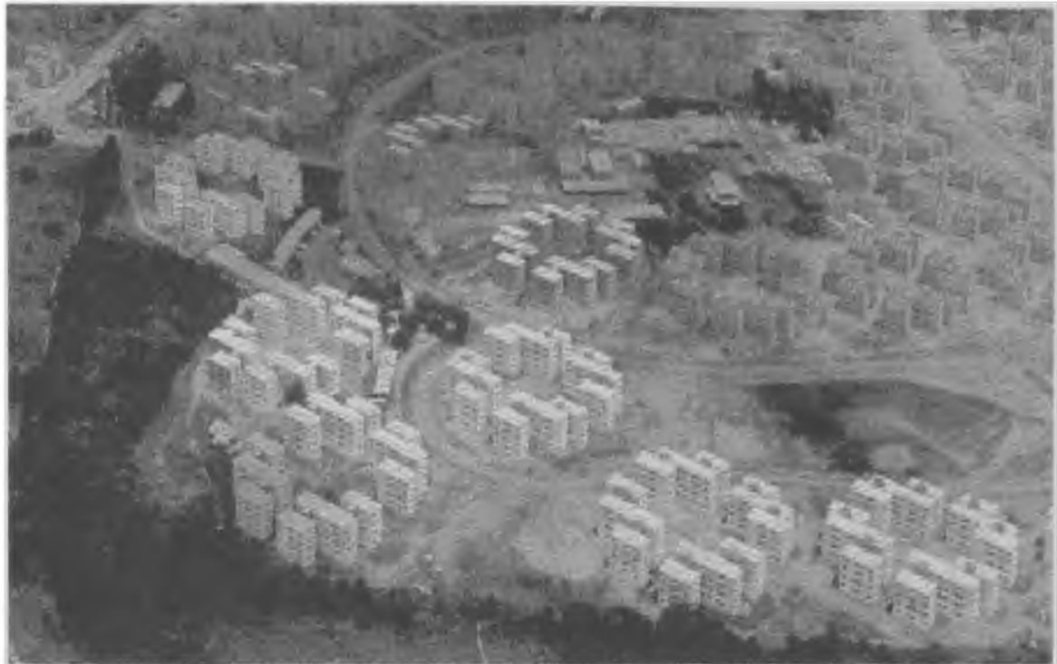
Figura 3: Estágio da construção do conjunto, pouco tempo após o início da obra Fonte: Prefeitura Municipal de Porto Alegre – PMPA
