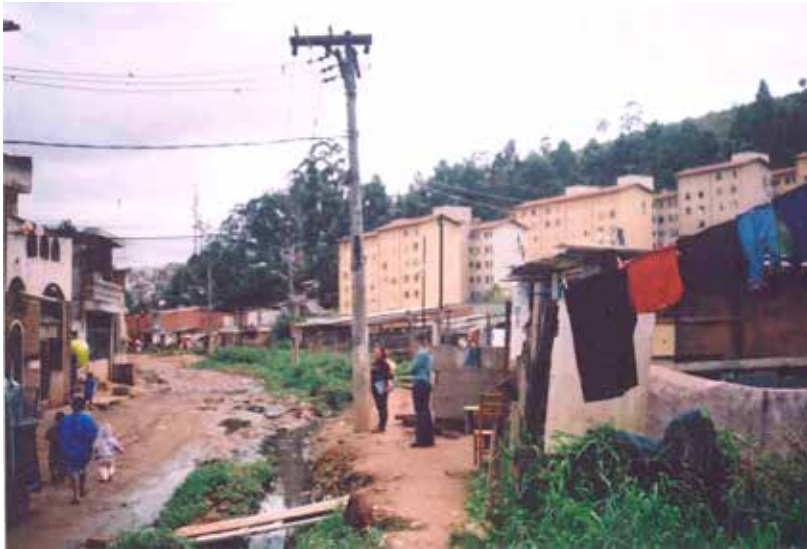
Figura 5 - Rua Hugo Ítalo Merigo antes da implantação do Parque Linear Canivete: ausência de calçadas, esgoto a céu aberto, pinguela, rua precária e favela. Foto: SVMA, 2006.
