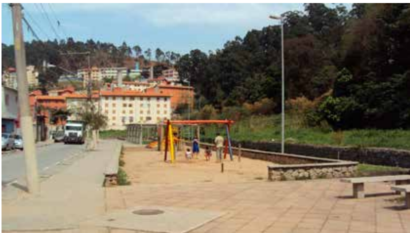
Figura 7 - Rua Hugo Ítalo Merigo, após a implantação do parque linear: rua asfaltada, calçada larga, equipamentos para lazer e fruição e córrego canalizado por gabiões. Foto: Wellington Tohoru Nagano, 2014.
