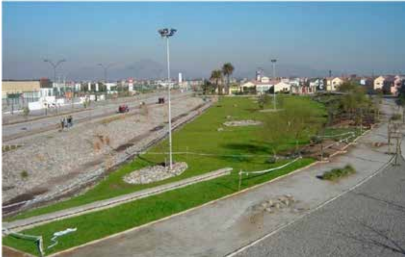
(a) Bacia de detenção aliado a técnicas paisagísticas e uso de lazer em Santiago do Chile
