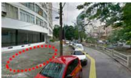
(d) Calçada no Trecho 1
