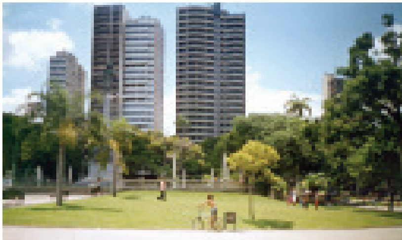
Ilustração 9 – Torres residenciais de elevado gabarito que se tornaram um significativo anteparo para as brisas da Baía de Guajará
