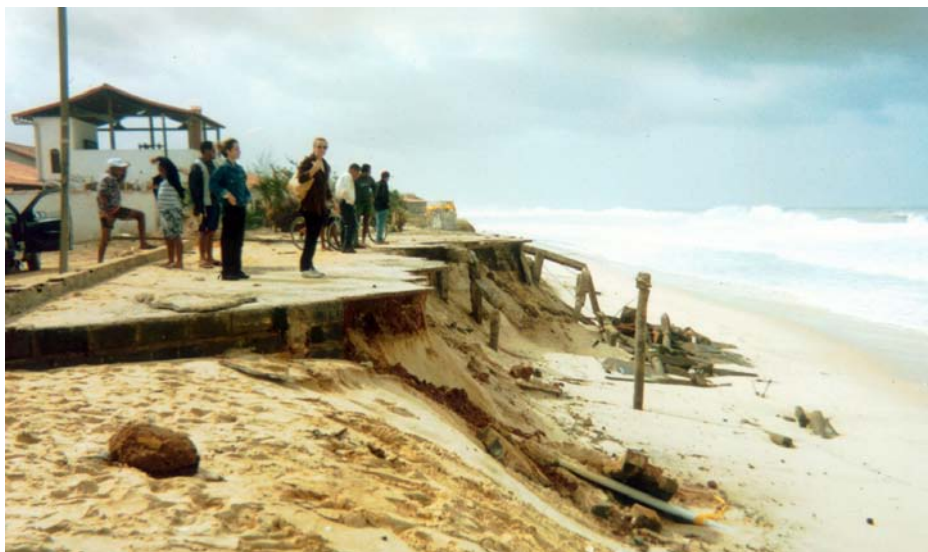
Foto 2: Destruição das construções em 2001
