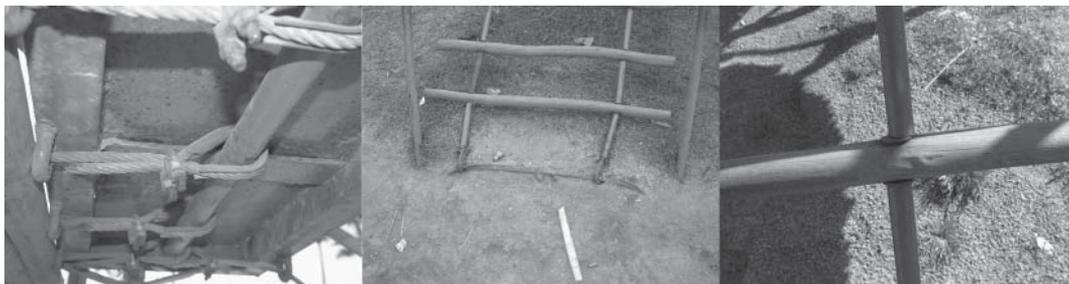
Figura 5: Detalhe da fixação dos cabos de aço da estrutura do brinquedo, da fixação dos cabos de aço na parte inferior da escada de madeira e do espaçador feito de tubo de aço para os degraus de madeira roliça.
