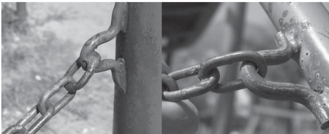
Figura 6: Detalhe de fixação das correntes
