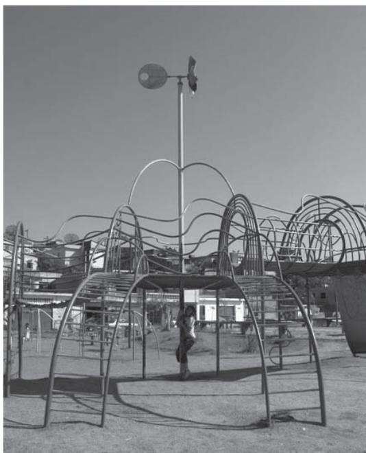
Figura 3: Brinquedo jacaré, mastro escorregador de bombeiro, feito com tubo de aço de 4" fixado à fundação através de solda em esperas chumbadas no concreto.
