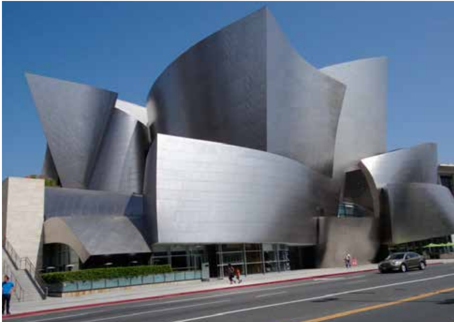
Ópera Disney, de Frank, Gehry, em Los Angeles (EUA). A introdução do computador no desenho arquitetônico permitiu a elaboração de formas arquitetônicas complexas até então inimagináveis. Os primeiros softwares de CAD para computador pessoal foram vendidos a partir de 1982; usava-se falar da “prancheta digital”. A partir da segunda metade dos anos 1990, acrescentaram-se possibilidades mais amplas de automação; nas perspectivas, em cores, textura, iluminação, transparências. Também passou a ser possível investigar o projeto arquitetônico por vários ângulos, inclusive em movimento, simulando percursos entre seus espaços. Foto: Silvio Macedo – 2013
