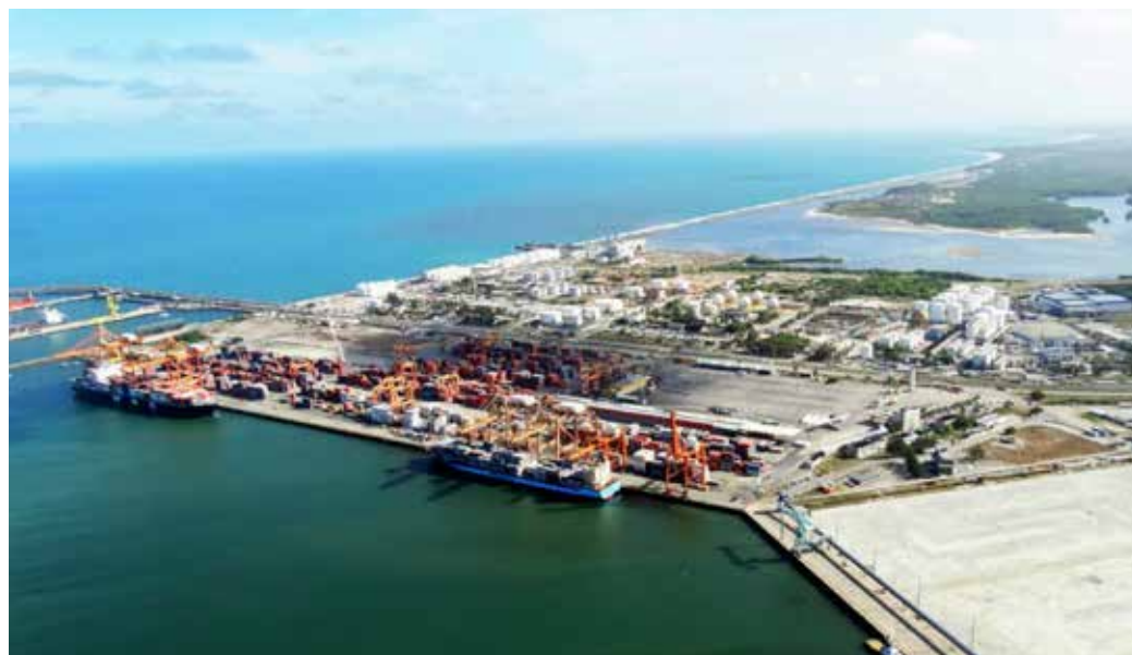
Figura 25 O porto de Suape, como outros tantos investimentos em infraestrutura portuária e ferroviária, demorou muito tempo para ser construído e, mesmo em 2016, ainda não estava concluído. Após anos de atraso, inúmeros investimentos não tinham saído do papel, aumentando muito as deficiências crônicas em infraestrutura do país. Foto: Silvio Soares Macedo, 2015.
