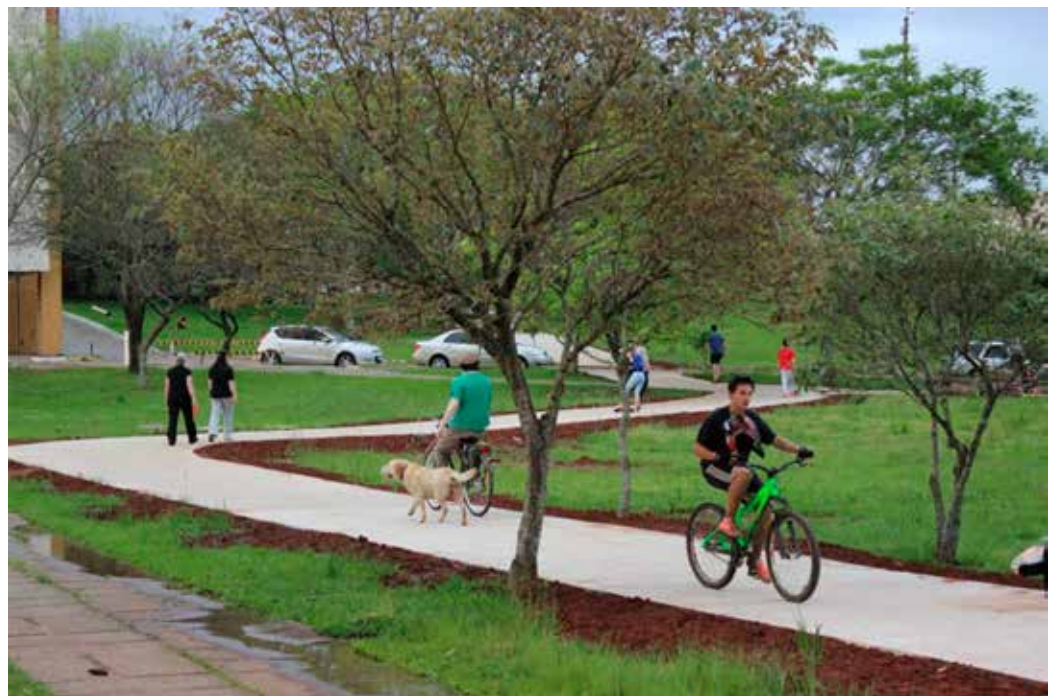
Figura 12 Acúmulo de água proveniente da chuva sobre o passeio em um local onde seria implantada uma trincheira de infiltração com vegetação adequada. Foto: Luis Guilherme Aita Pippi, 2014.
