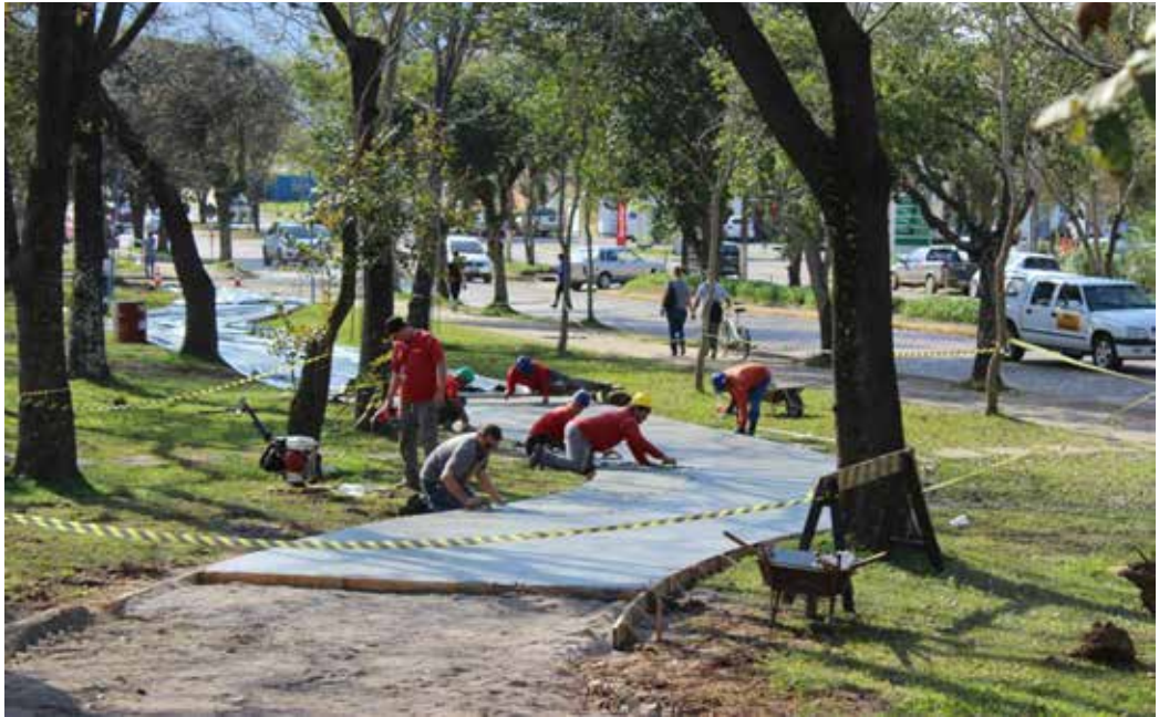
Figura 14 Execução da Pista Multiuso iniciada em julho. Vista 1. Foto: Felipe Gravina, 2014.
