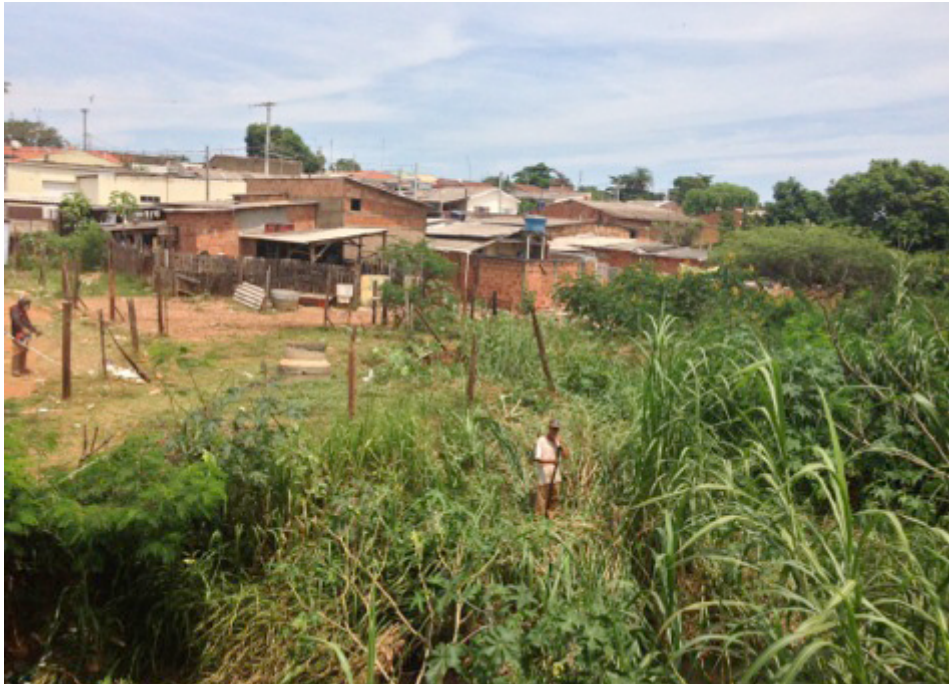
Figura 10 Visita de campo feita pela equipe do PET. Ocupação das margens do córrego da Lagoa. A prefeitura já iniciou o processo de remoção de famílias em áreas de risco junto ao córrego. Foto: Danilo Pena Maia, 2015.
