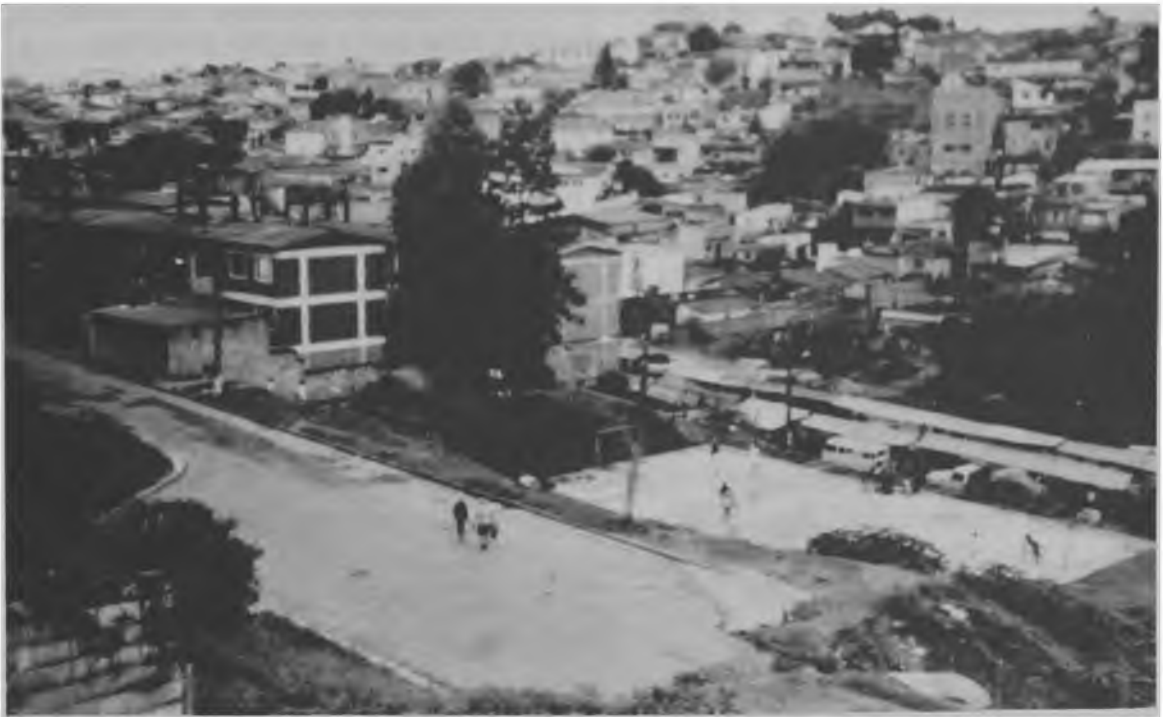
Fig. 45 - Execução de plataformas para uso de atividades esportivas
