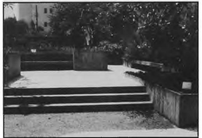
A piscina foi elevada em relação ao piso do térreo, mas o desnível foi distribuído em patamares intermediários
