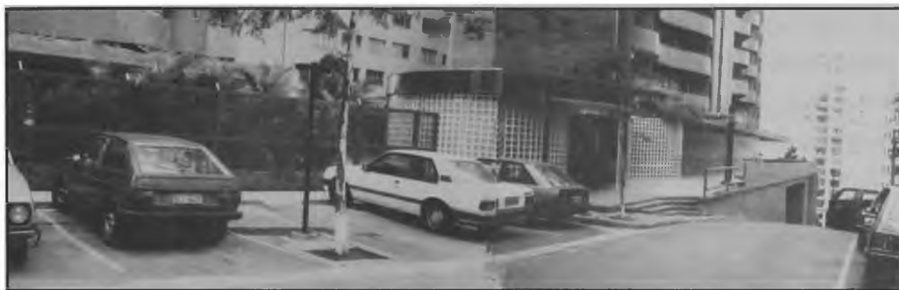
O térreo do condomínio Portal da Cidade foi projetado pelo arquiteto Ruy Othake, mas o projeto de plantação foi feito por Sidney Linhares. Bastante contemporâneo possui portaria com tijolos de vidro
