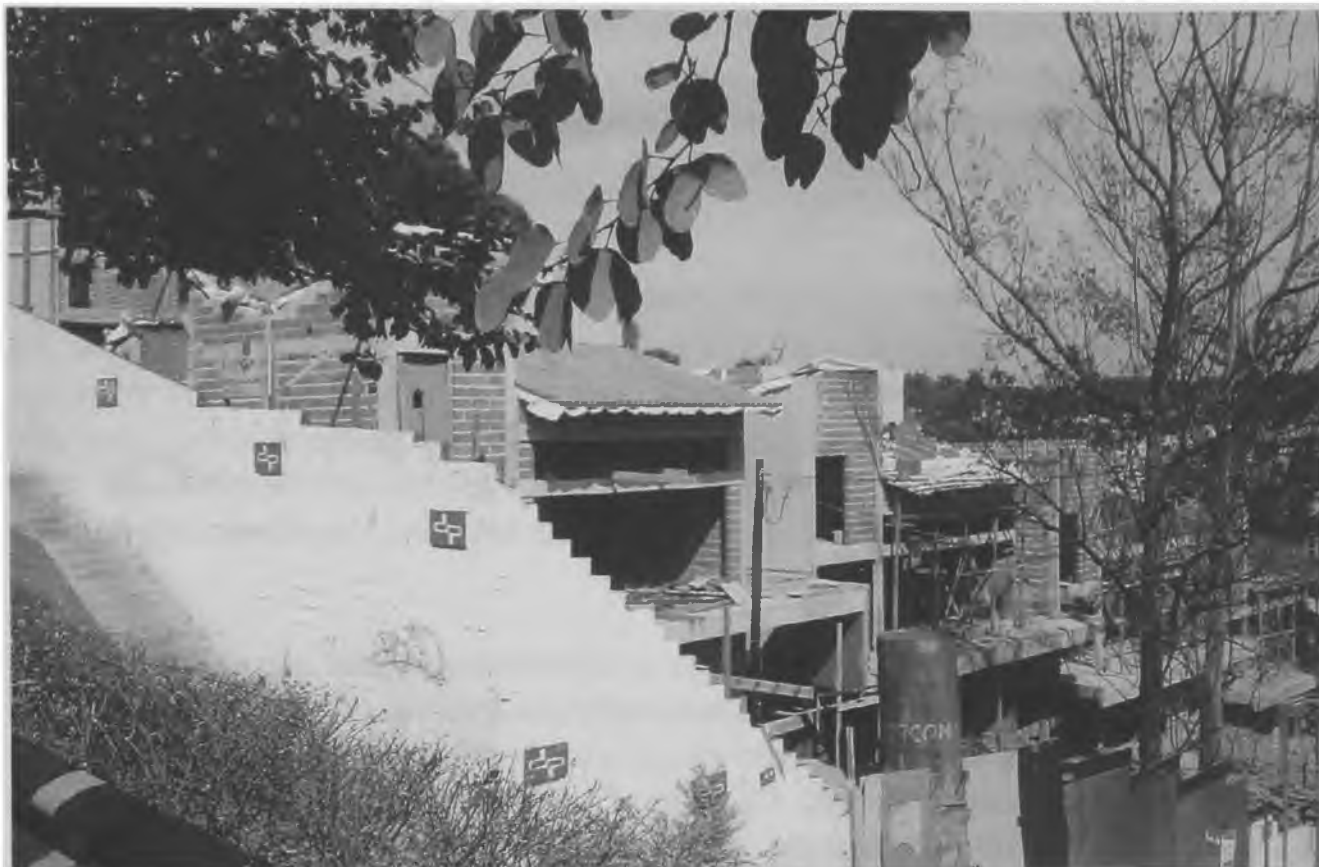
Foto 18: Brooksville na época da construção. As casas acompanham o terreno Fonte: Foto da autora
