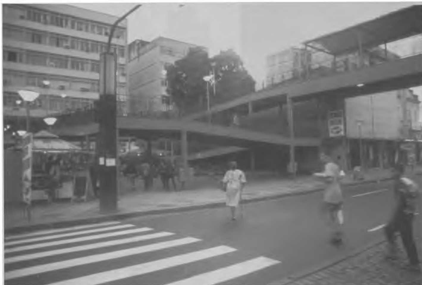
Foto 6: A passarela foi reformada, estendida e dotada de novas rampas e cobertura, conectando os dois lados da via férrea e as duas únicas praças de porte do Méier
