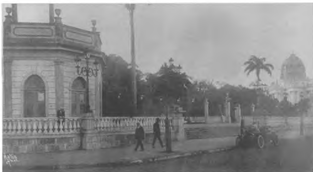
Figura 18: O espaço do terraço, com a construção da avenida Beira-Mar, não mais pertence ao Passeio Público Fonte: Augusto Malta (AGCRJ)
