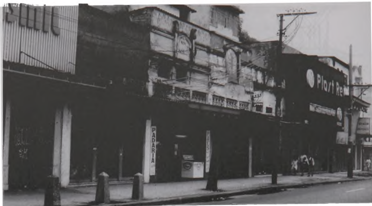
Casario na rua 24 de Maio, junto à linha férrea, no Meier Fonte: Foto de Marcos London, 1999 – Arquivo PUZN
