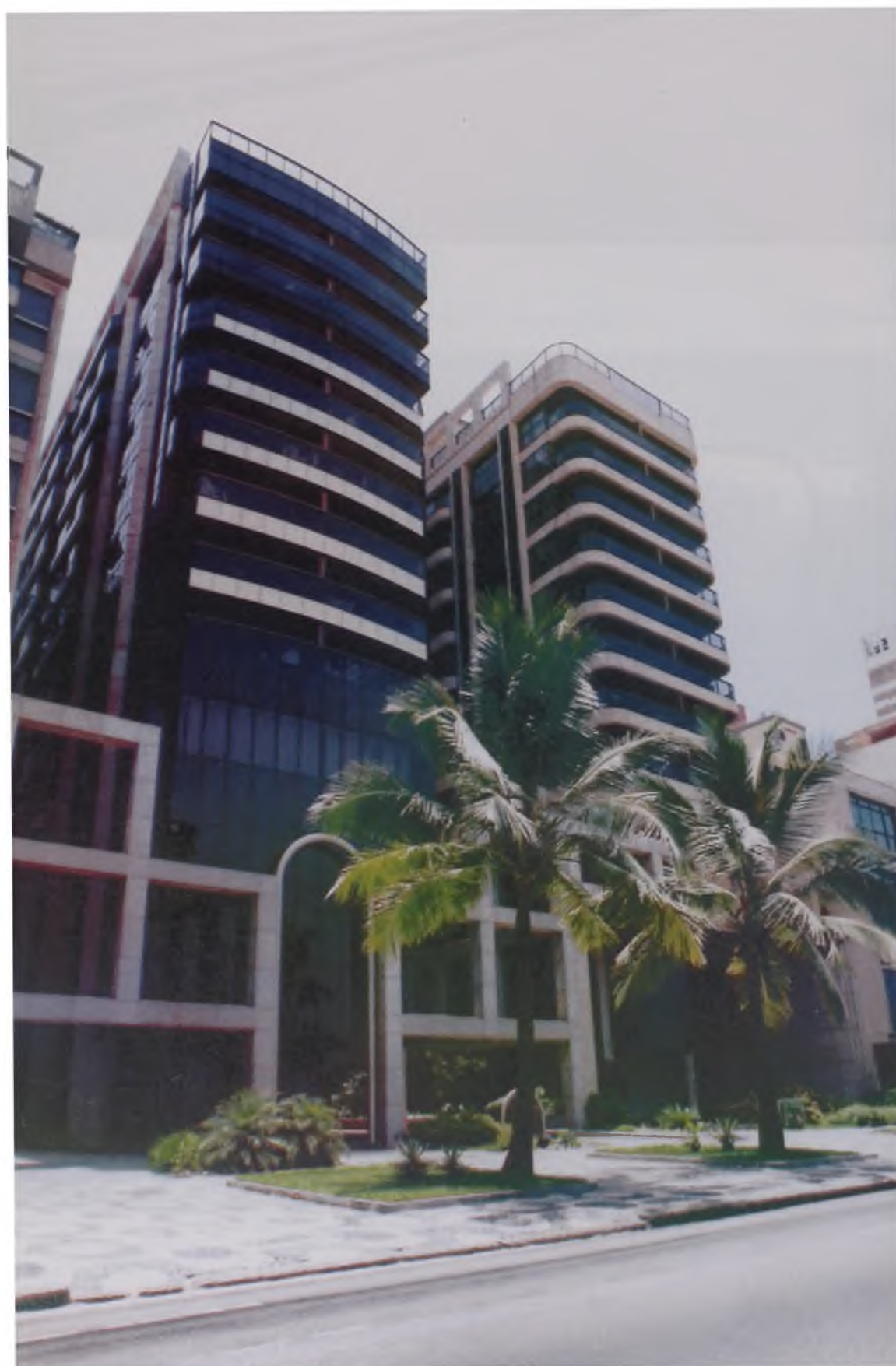
Conjunto de edifícios, em Ipanema Fonte: Foto de Marcos London, 1999 – Arquivo PUZN
