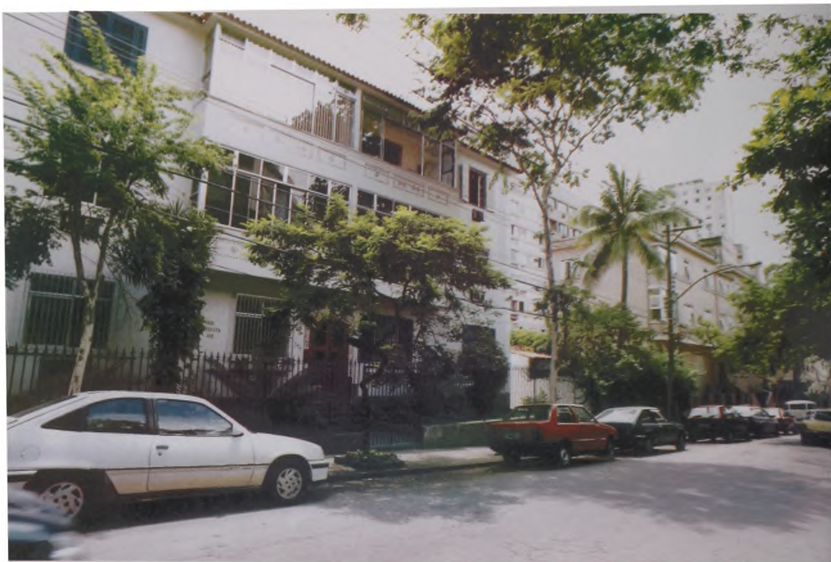
Prédio de três pavimentos, em Laranjeiras Fonte: Foto de Marcos London, 1999 – Arquivo PUZN
