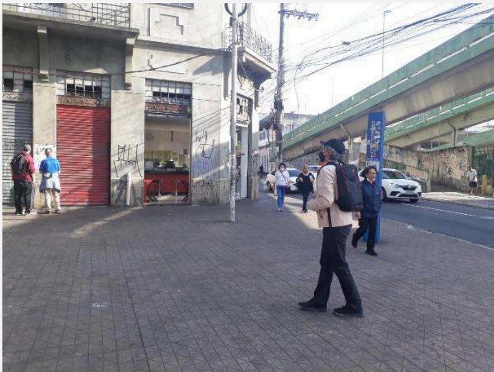
Figura 5: parte da fachada lateral da edificação tombada conhecida como Nosso Bar. Esse trecho fica defronte da linha férrea. Foto: Paulo Tácio, 2022.
