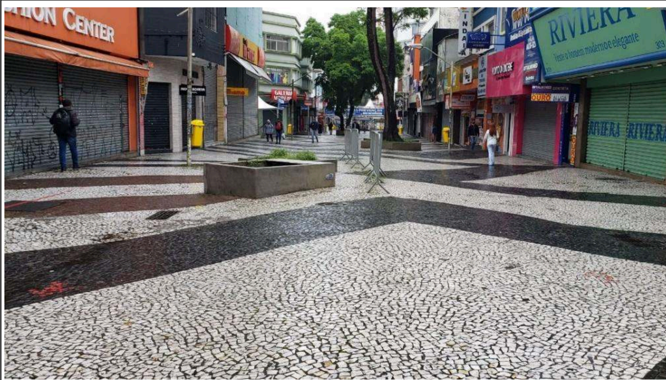
Fiaschi, instalado em 1978. O projeto foi realizado em parceria com Luciano Fiaschi em 1978. Composto por desenhos geométricos realizados por toda a extensão da rua Cel. Oliveira Lima e Praça do Carmo, somente nos anos 2000 o piso foi parcialmente substituído com instalação da pro
