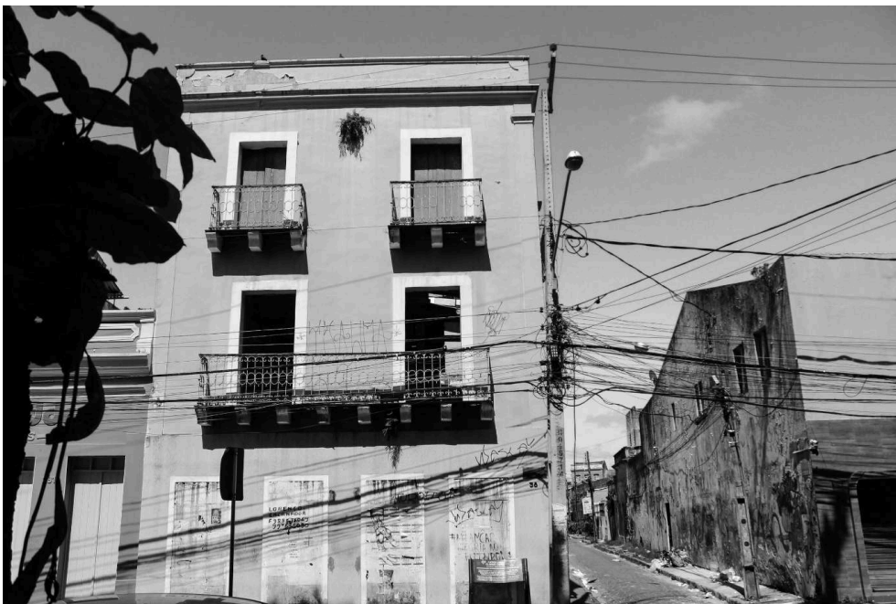
Imagem 3 - A casa da escritora Clarice Lispector fica localizada na esquina da Rua do Aragão com a Travessa dos Veras, no bairro da Boa Vista. Sob administração da Santa Casa do Recife, a construção observa-se partes que desabaram internamente, enquanto por fora pichações marcam sua fachada, a qual possui uma placa em estado similar a casa. Segundo a Santa Casa, um processo de tombamento está em andamento desde 2017..
