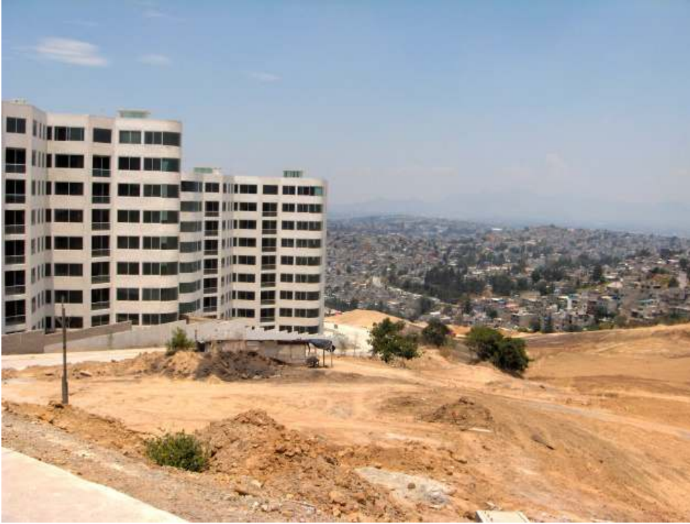
Figs. 4.5 y 4.6: Fraccionamiento Bosque Real: Arriba Country Club; abajo algunos de los edificios departamentales en construcción frente al entorno de pobreza que le rodea
