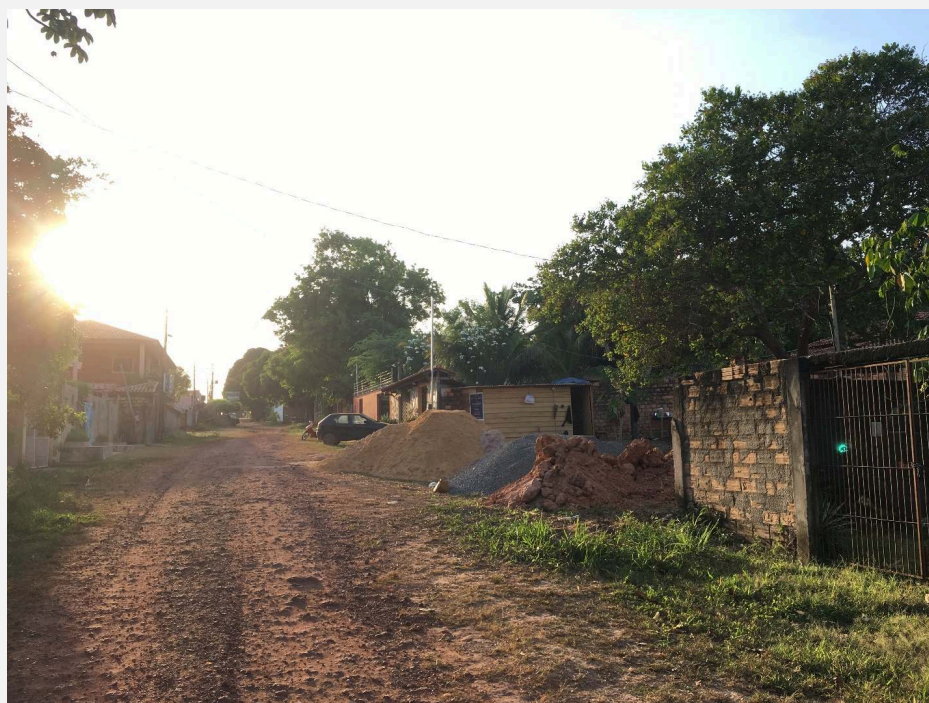
Rua com terreno em obras em setembro de 2018
