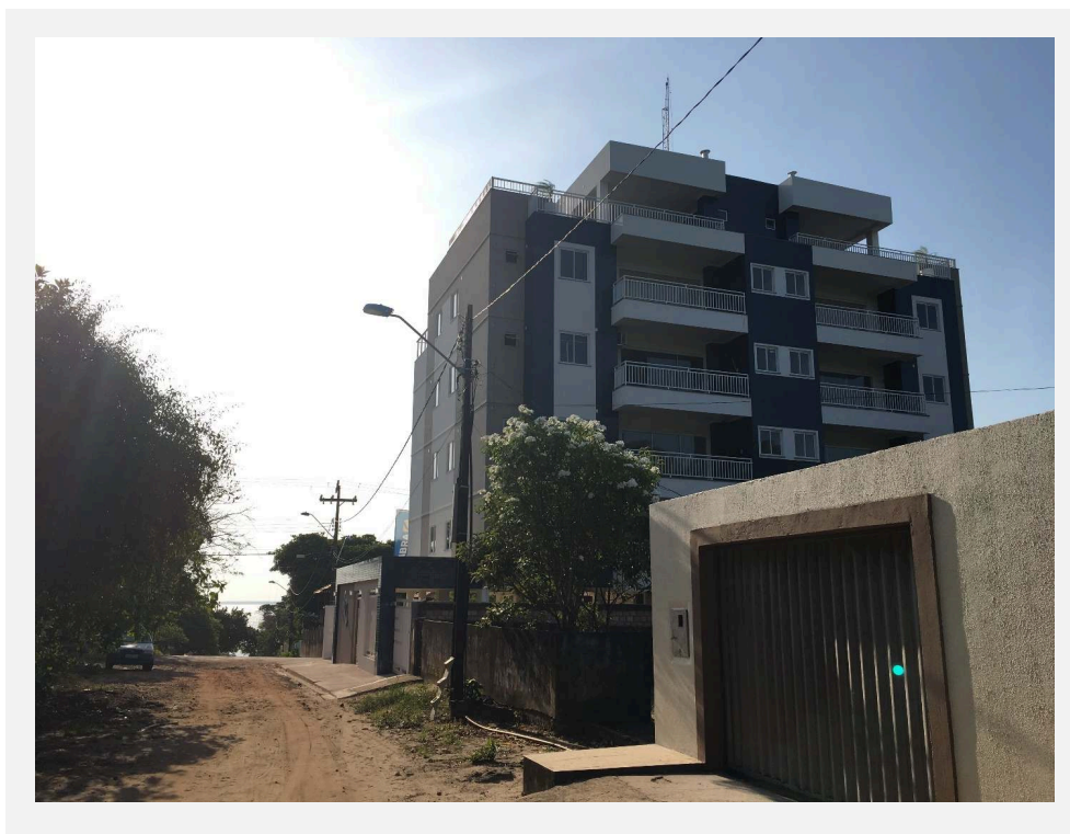
Prédio recentemente construído na vila e alvo de polêmica sobre sua ilegalidade.
