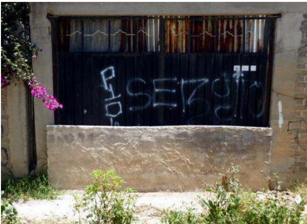
Imagen 4. Pared de concreto en la entrada de una vivienda.
