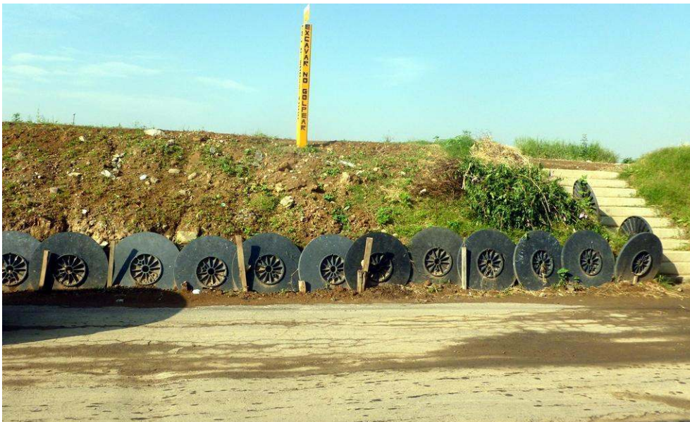
Imagen 5. Diques con discos de plástico en el perímetro del Río de los Remedios.
