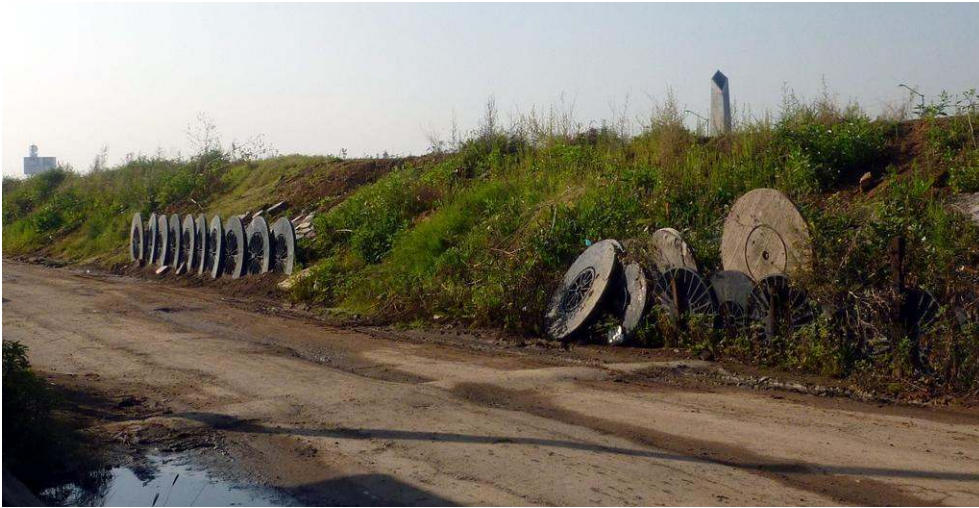
Imagen 6. Diques con discos de plástico en el perímetro del Río de los Remedios.
