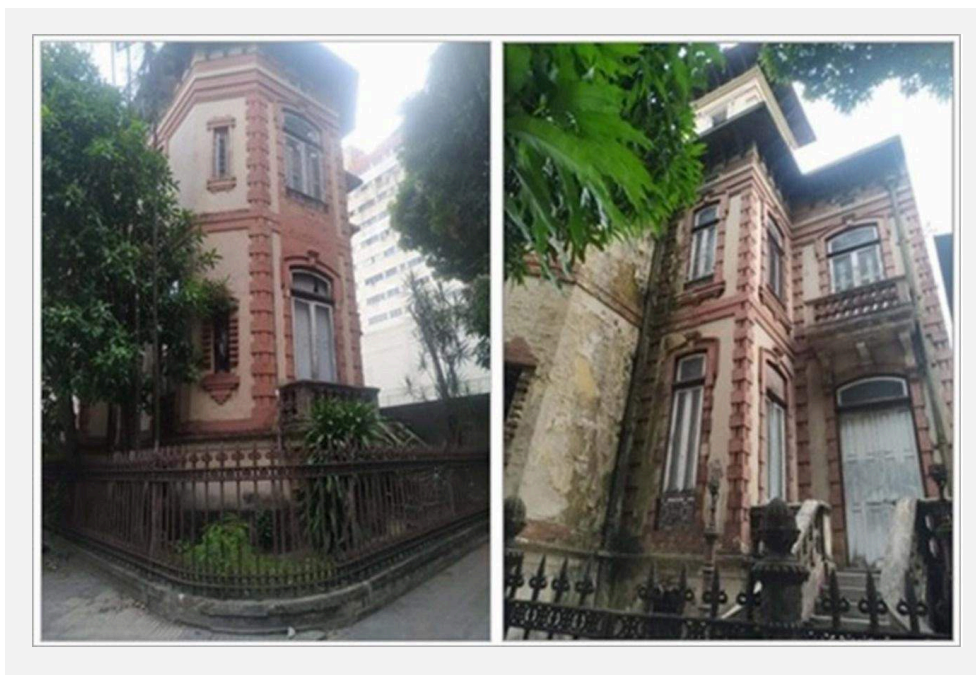
Figura 6: Detalhes da entrada principal do Palacete pela “José Malcher”. Fotos da autora, 2022.
