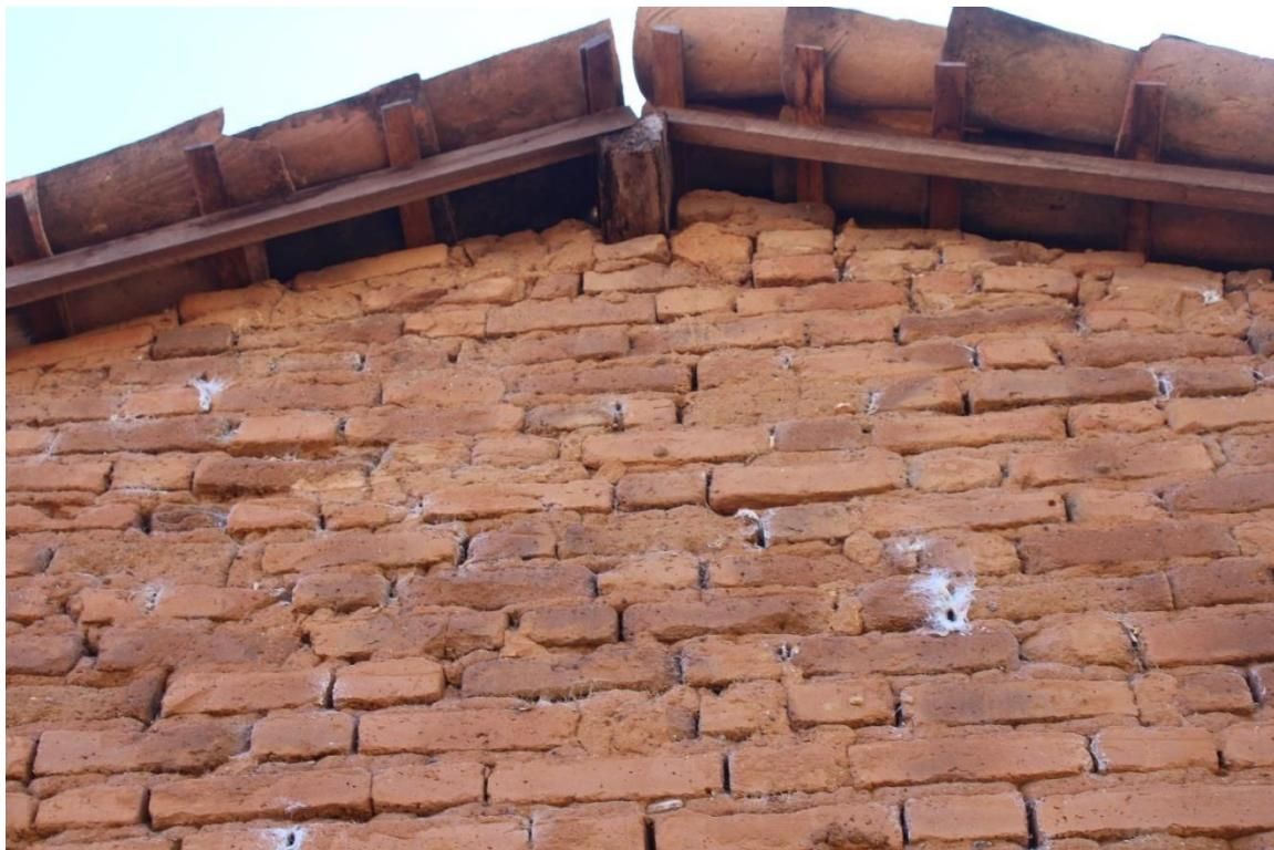
Figura 5: Parte externa da casa, evidenciando a sobreposição dos tijolos de barro e parte das telhas que compõem o telhado da residência. Fonte: Ribeiro, 2023.
