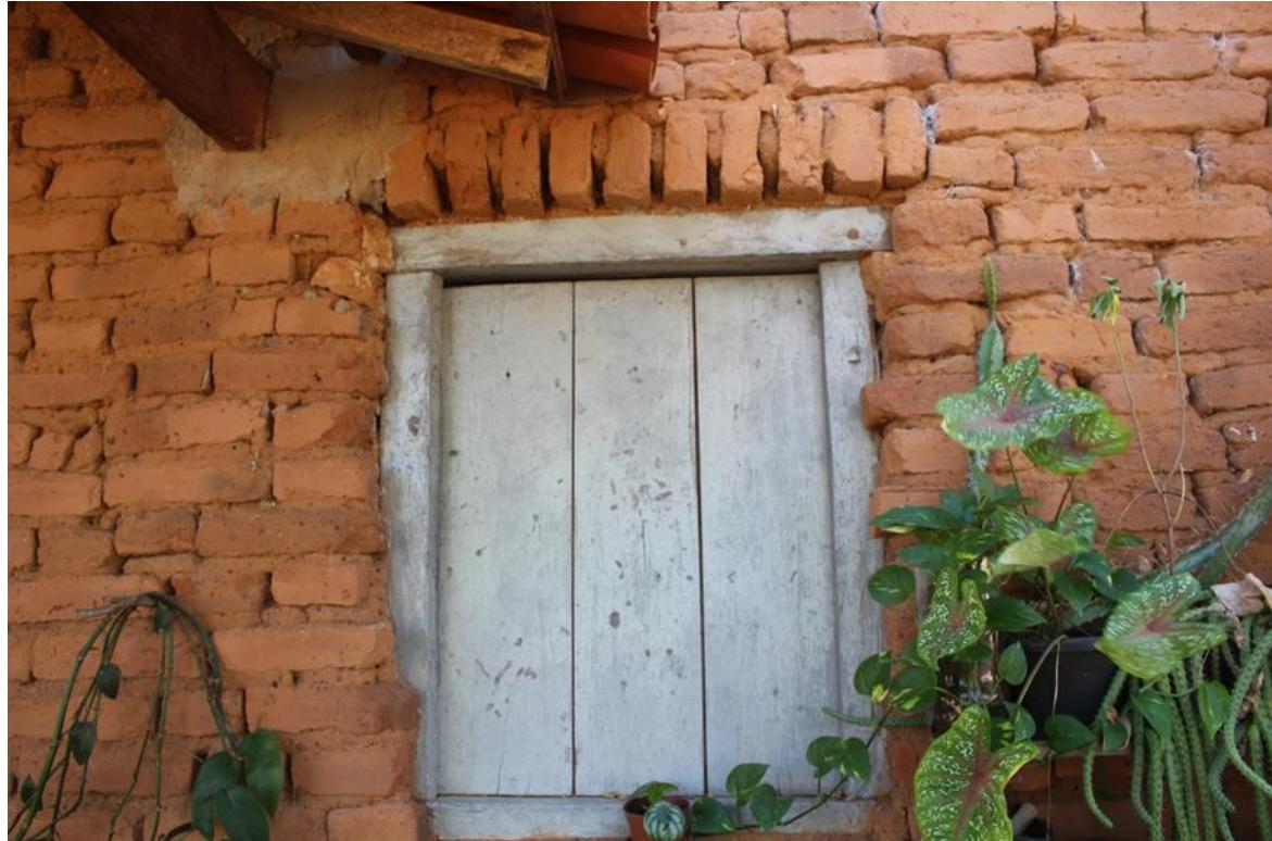
Figura 2: Detalhes arquitetônicos da casa de dona “Nanzinha” e João Gualberto. Janela da lateral esquerda da casa, construída em tijolos de barro cozidos, e sem reboco, e na parte superior a utilização de tijolos em posição vertical, com presença das plantas ornamentais em volta, compondo o jardim da casa. Fonte: Ribeiro, 2023.
