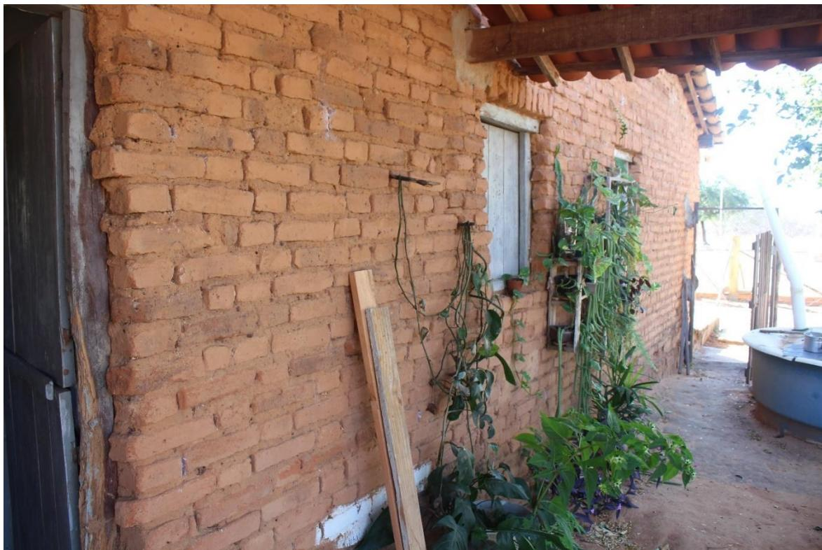
Figura 3: Arquitetura vernacular na comunidade Lagoa de Fora, com detalhes para a aparente sobreposição de tijolos de barro, técnica repassadas de geração para geração. Fonte: Ribeiro, 2023.
