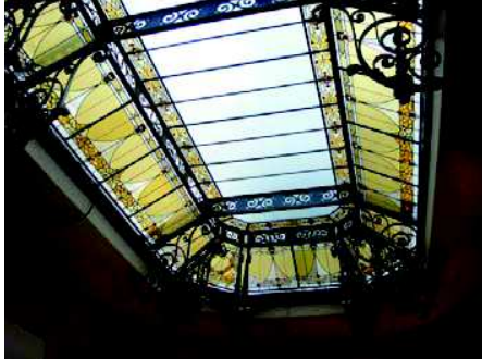
Figura 13: Posicionamento da Cúpula no último pavimento do Centro Cultural Banco do Brasil. Fonte: Foto da autora.
