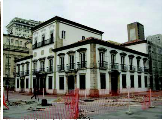
Figura 17: Centro Cultural Paço Imperial após a intervenção. Fonte: Foto da autora.
