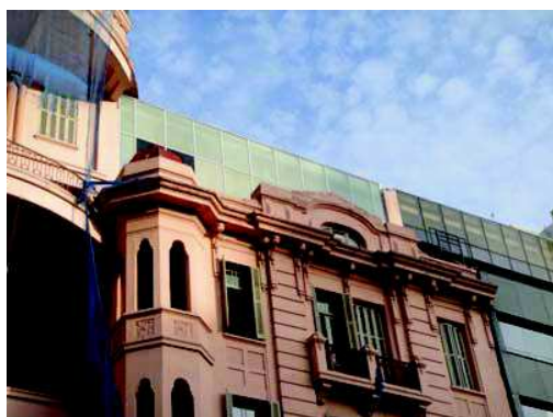
Figura 7: Casa de Cultura Mário Quintana: fachada posterior onde foi incorporada a cobertura em estrutura metálica e vidro. Fonte: Foto da autora.
