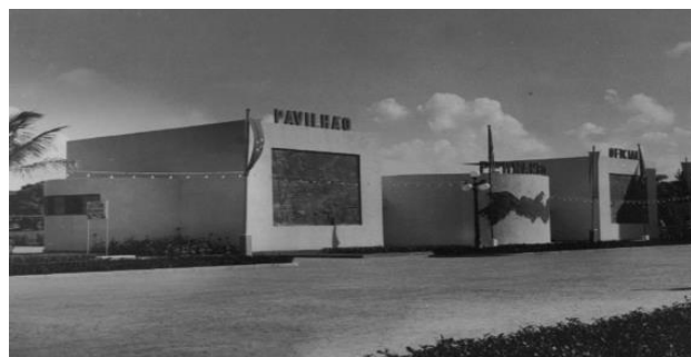
Figura 12 – Pavilhão do estado de Pernambuco. Fonte: BELLO (2006).
