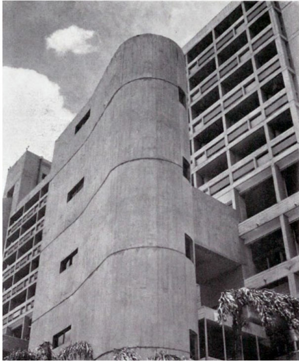
Imagen 5. Torre de circulación edificio IPSM. Fuente: Revista Summa N° 8. Año: 1967
