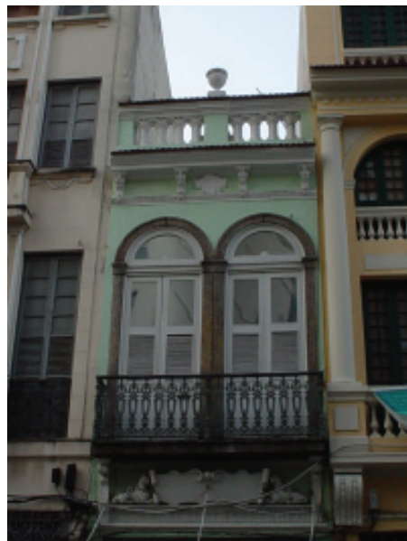
Foto 13: Corredor Cultural – Rua Sete de Setembro, n. 137 – RJ Crédito: Autor
