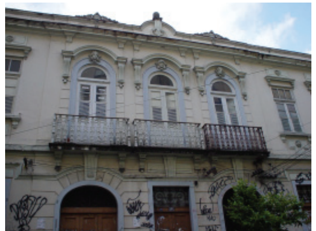
Foto 10: Corredor Cultural – Avenida Mem de Sá, s/n – RJ Crédito: Autor
