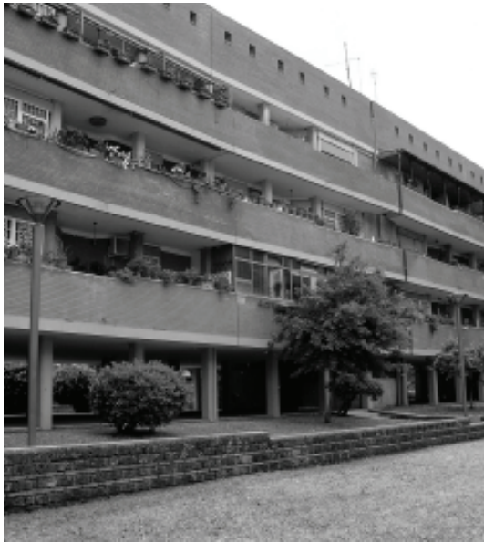
Figura 17: Decima. Com o decorrer do tempo, verificou-se um fechamento, total ou parcial, das aberturas, com a intenção de aumentar a área habitável: esses acréscimos, todos diversos, sem nenhum critério comum, alteraram fortemente o aspecto dos edifícios e da composição unitária do bairro
