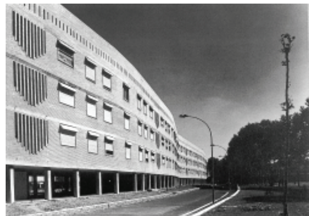
Figura 14: Decima. Foto da época da conclusão das obras Fonte: BUCCI, F.; MULAZZANI, M. Luigi Moretti. Opere e Scritti . Milão: Electa, 2000
