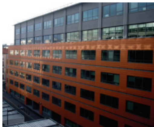
Figura 3: Fachada semicortina (após renovação), cujos componentes de fechamento são placas cimentícias com acabamento incorporado Foto: Autores, Paris, 2007
