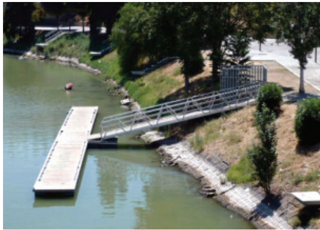
Figura 6: Passeio de Nossa Senhora do Ó: obra realizada Foto: Autor
